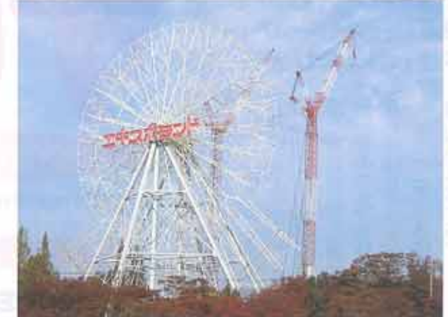
観覧車の解体始まる 11月9日(写真①)
