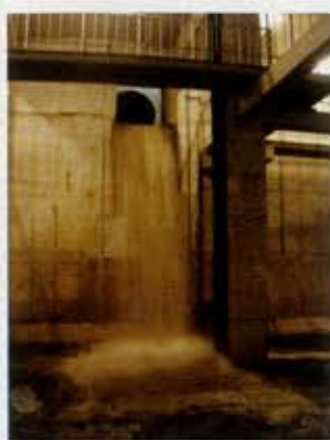
大雨時には「上の川」の雨水が流れ込む仕組み
