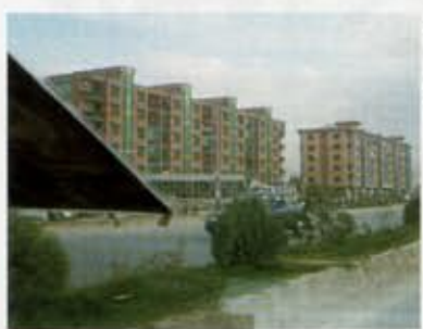
カブールで建設中の高級マンション。貧富の差が広がっている
