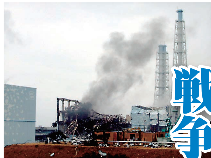
福島第一原発事故、爆発後の3号機 (提供: TEPCO/アフロ)
